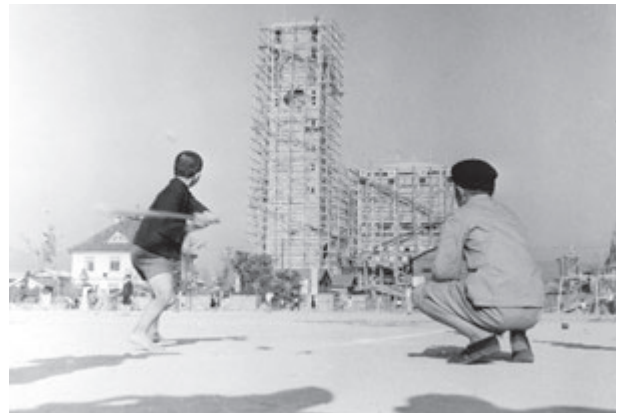
世界平和記念聖堂は、原爆犠牲者の追悼と慰霊、また全世界の友情と平和のシンボルとして1950年8月6日に着工、1954年8月6日に完成。現在でもランドマークになっている。1953年(昭和28年) 鞆町小学校から撮影
