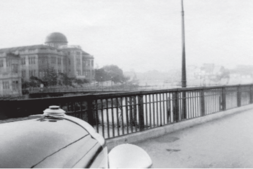
昭和初期の産業奨励館を相生橋から望む 撮影:松本若次 (提供:川本静枝)
